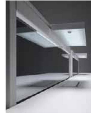
Luminarias individuales sobre pórticos / Luminaires individuels sur portiques / Lighting fittings on portal frames.
